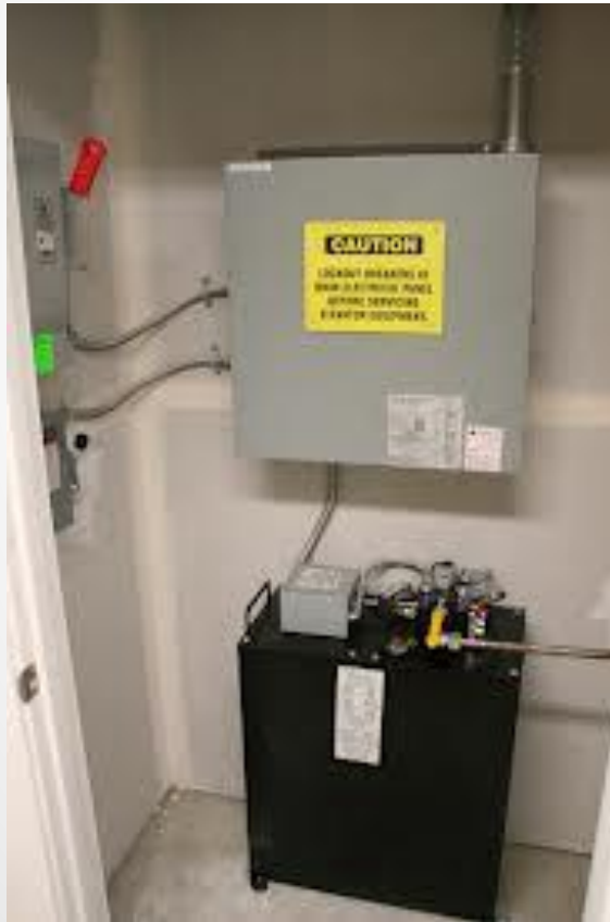
إمكانية فصل التيار الكهربى يدوياً عن المصدر من داخل غرفة الماكينات
