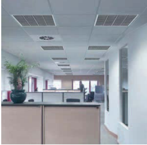
نلاحظ أنه في الأجهزة التي لها عاكس أن الضوء محجوب والجدران والسقف معتم أكثر من الصورة الأولى مع أن مستوى الإنارة على سطح العمل هو متساو في الحالتين
