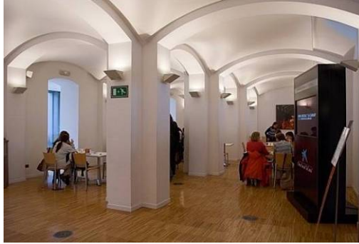
جهاز معلق على الجدار مباشرة للإنارة الغير مباشرة-ينير السقف
