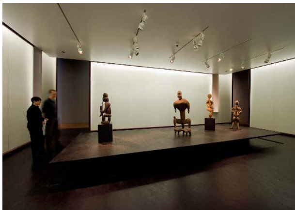
سكك غاطسة في السقف بحيث يمكن تحريك أجهزة السبوت لايت على مسار السكة أو إزالتها ونقلها من سكة لسكة أخرى
