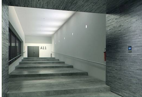
جهاز غاطس في الجدار للإنارة الغير مباشرة-ينير السقف
