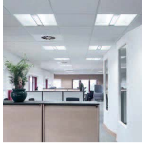
نلاحظ أنه في الأجهزة التي لها ناشر ينتشر الضوء ويكون السقف والجدران مضيئين
