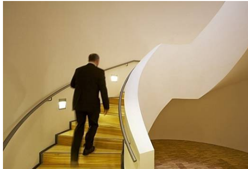
جهاز غاطس في الجدار لإنارة الأرضية
