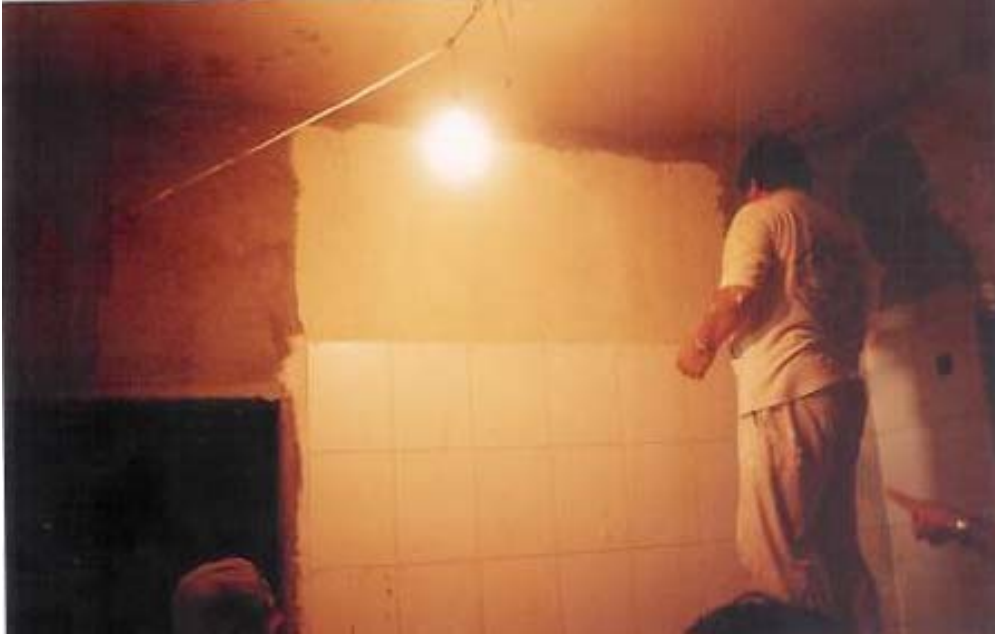
شكل رقم ٤٥ - طريقة الفرش الرقيق بمادة لاصقة تفرش على الحائط
