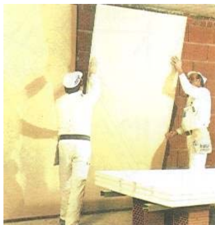
شكل رقم ٨١ - ألواح الجبس المعالج العازلة للحرارة
