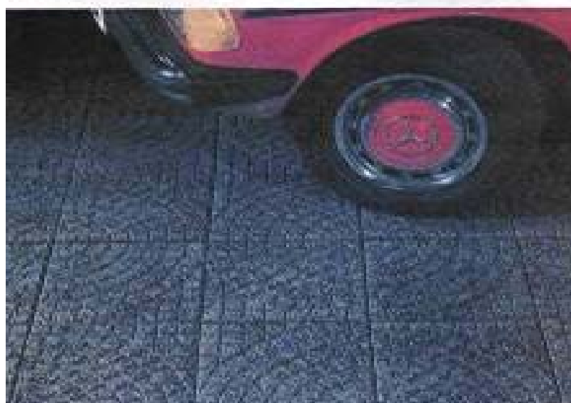
( ب ) بلاط أسمنتي مقوى ببرادة الحديد "ستيل كريت"
