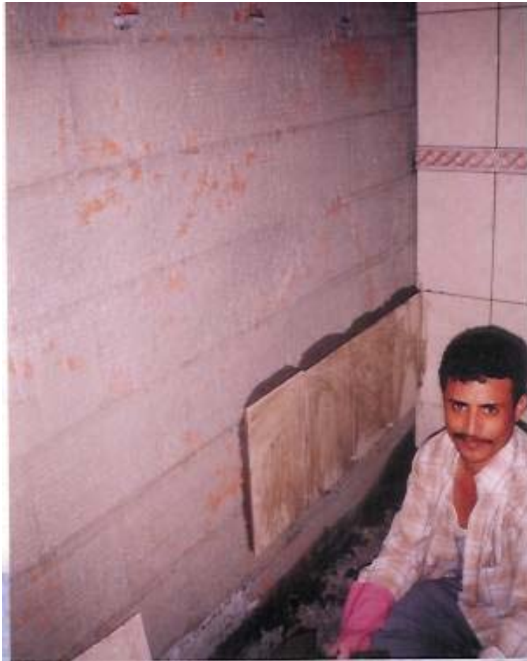
شكل رقم ٤٤ - طريقة الفرش السميك بالمونة لكسوة بلاطات السيراميك على الحوائط
