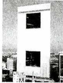
منظور خارجي للمبنى [١٠، ص ٤٩]
