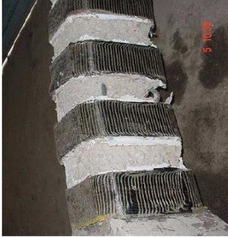
الشكل (12-2): عمود مقوى بشرائح الـ CFRP - (C-S-2-10) , [ Mahmoud et al ,2004 ]
